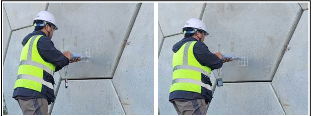
【그림 1.3.6】 슈미트해머를 이용한 반발경도시험 전경
